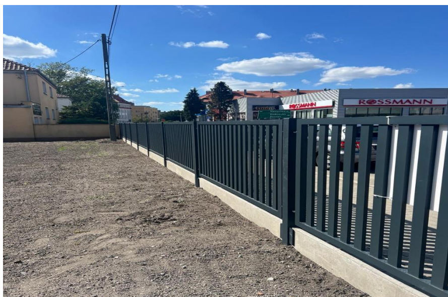
Fot. PPnr 7: Budynek PP nr 7 z Oddziałami Żłobkowymi po zmianie kolorystyki elewacji. Wymienione ogrodzenie.
