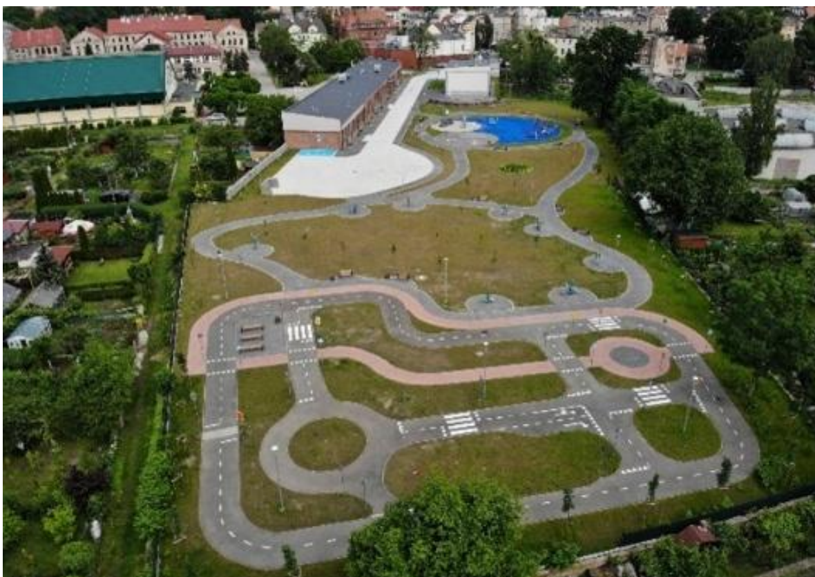
Fot. Gmina Kluczbork; Budynek Zakładu Aktywności Zawodowej w Kluczborku na terenie Centrum Kluczborska Bajka-widok z lotu ptaka
